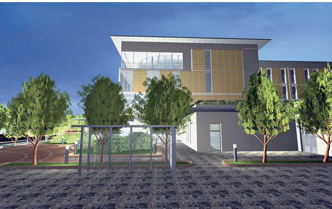
Il potere isolante delle vetrate è affidato a un sistema di veneziane esterne, mobili e impacchettabili
