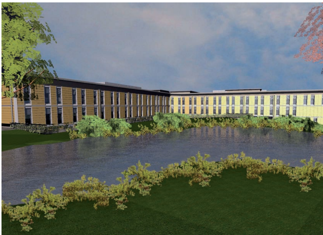
Le parti opache delle facciate sono composte da pannelli prefabbricati ad alto coefficiente d'isolamento termico e acustico
