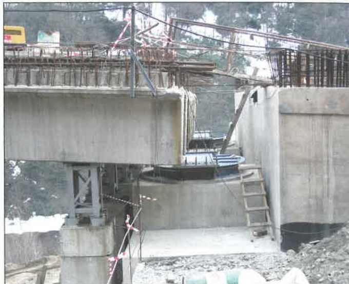
Le opere di "retrofitting" per il recupero dell'opera
