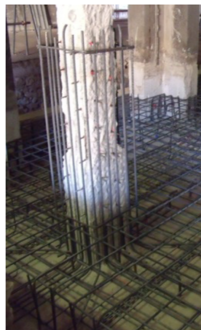
Sopra dall'alto verso il basso. Disconnessione dei muri al piano di fondazione per consentire il movimento della sovrastruttura. Rinforzo dei pilastri in ca e nuova platea di rinforzo.
