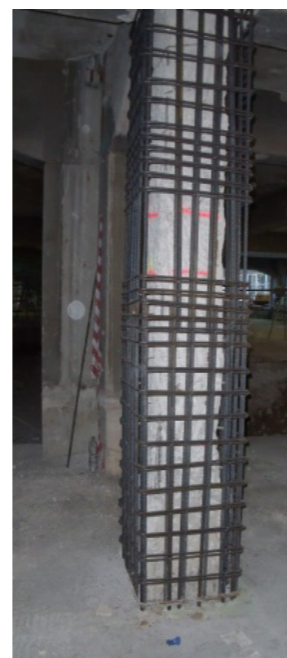
Sopra dall'alto verso il basso. Disconnessione dei muri al piano di fondazione per consentire il movimento della sovrastruttura. Rinforzo dei pilastri in ca e nuova platea di rinforzo.
